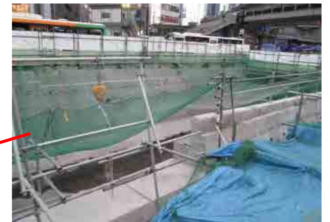
区画整理事業中に一時的に姿を現した昭和30年代に作られた渋谷川の旧護岸。駅側からバスターミナル方向を見る。
