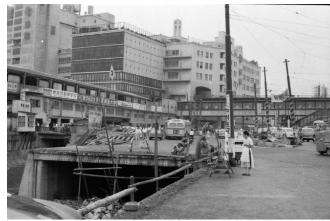
ふたをかけた状態で新水路（護岸）が一部完成しているが、水はまだ旧水路を流れている。
