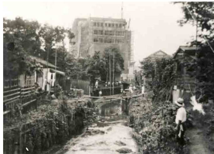
建設中の東横百貨店と渋谷川（昭和8年頃）
