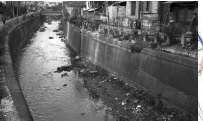
下流から八千代橋を望む(昭和36年)
