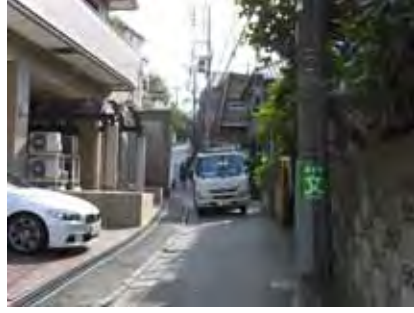
配送等の車両も通りづらい 災害時の避難もしづらい
