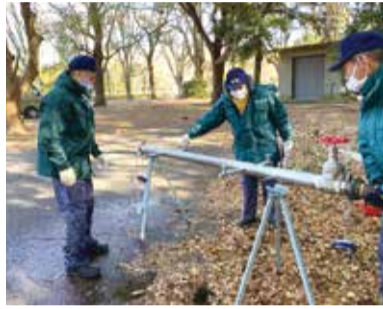
▲代々木公園応急給水施設の点検
