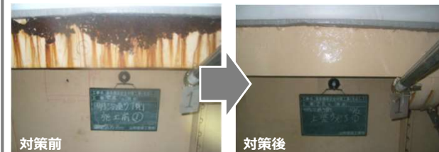
塗装が劣化し、腐食が発生
