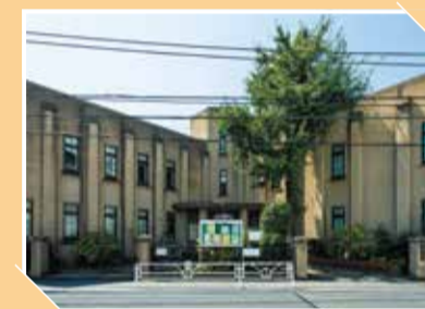
▲ 塙保己一史料館の外観。昭和2年に鉄筋コンクリートで建設された。
